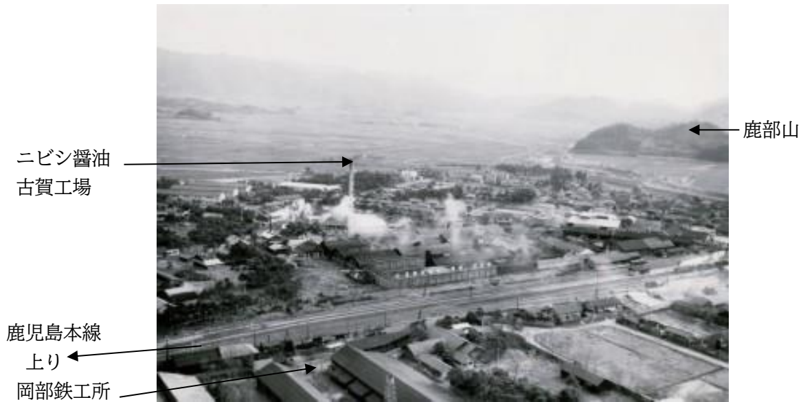
図6 古賀駅東側周辺 写真提供：ニビシ醤油株式会社
