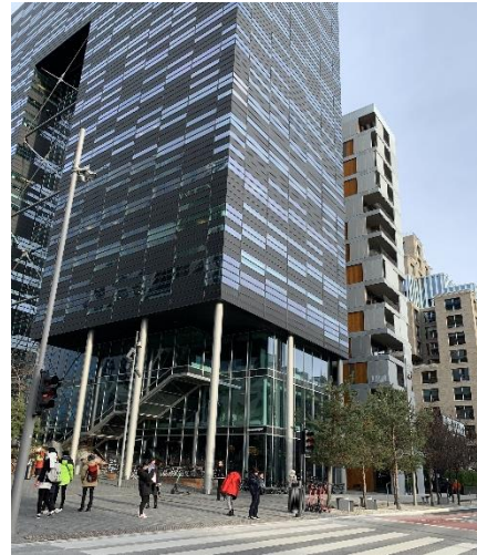
図3 バーコードビル
