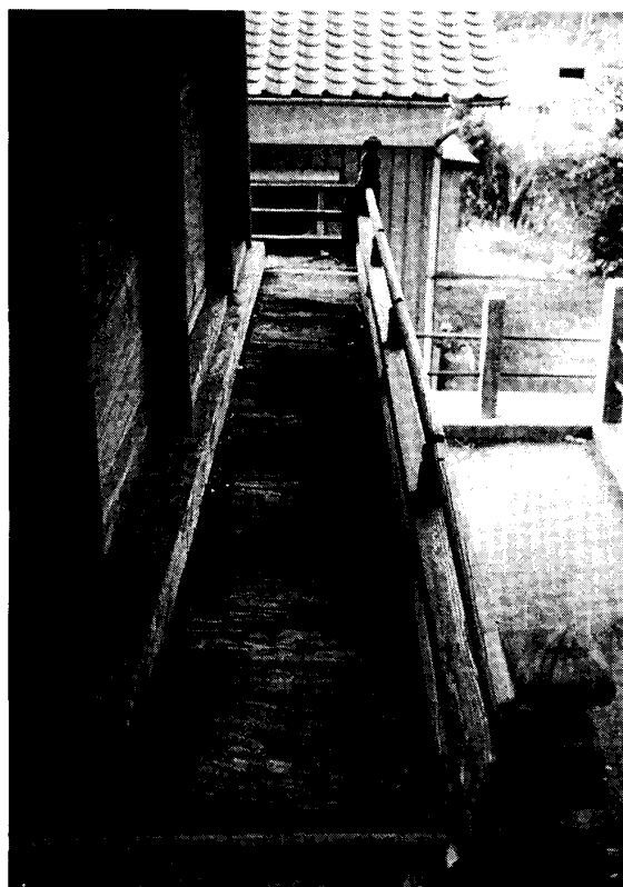
(写真-6) 高欄付き切目縁
